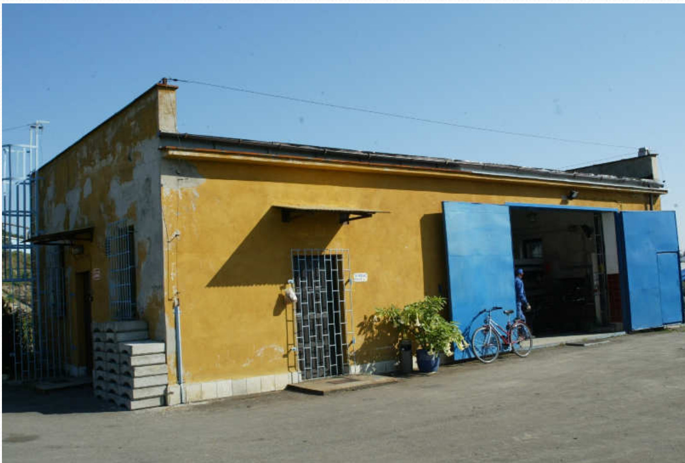
Stacja odwadniania osadu
