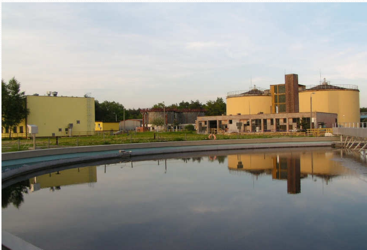
Kotłownia z komorami fermentacyjnymi
