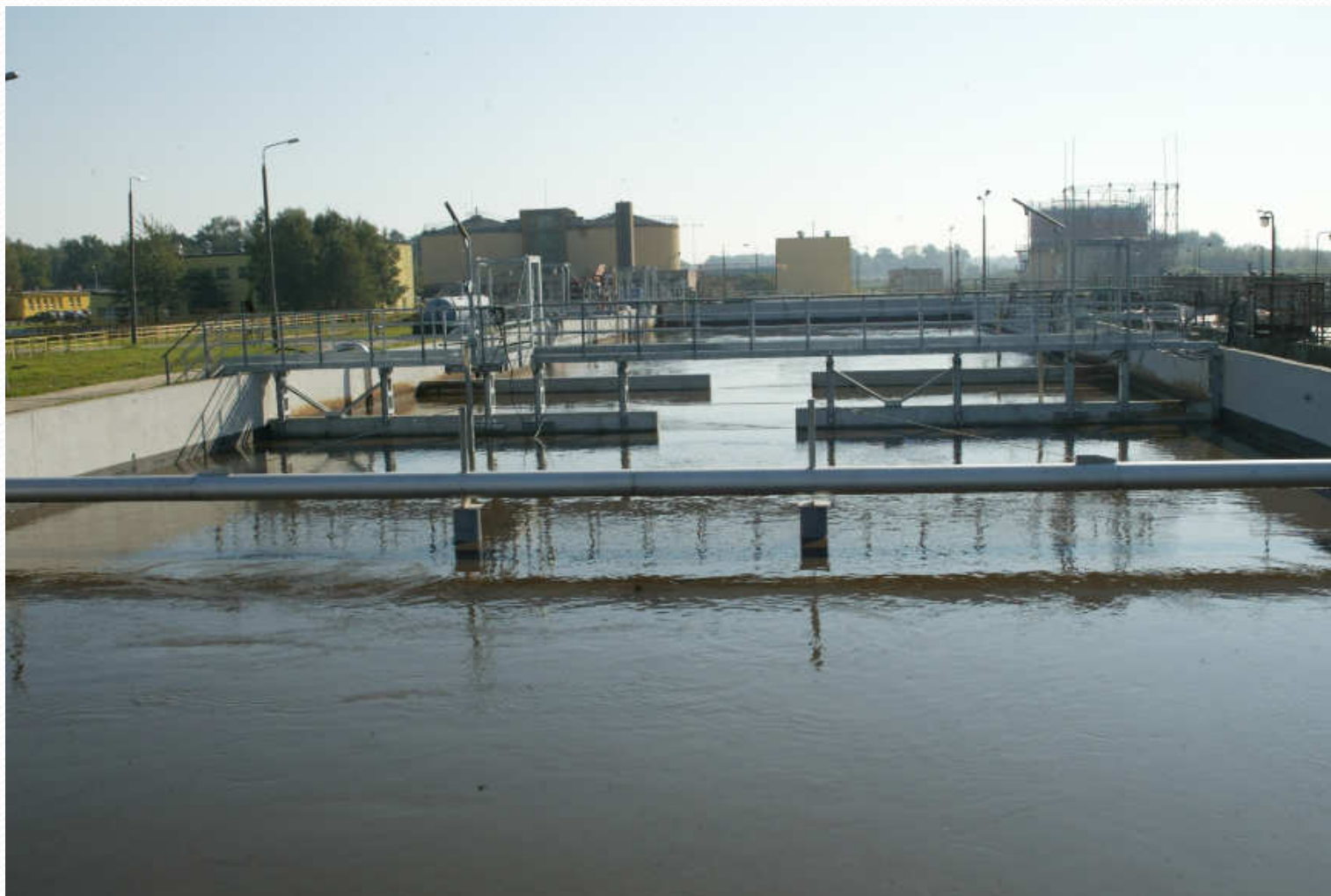
Komory osadu czynnego
