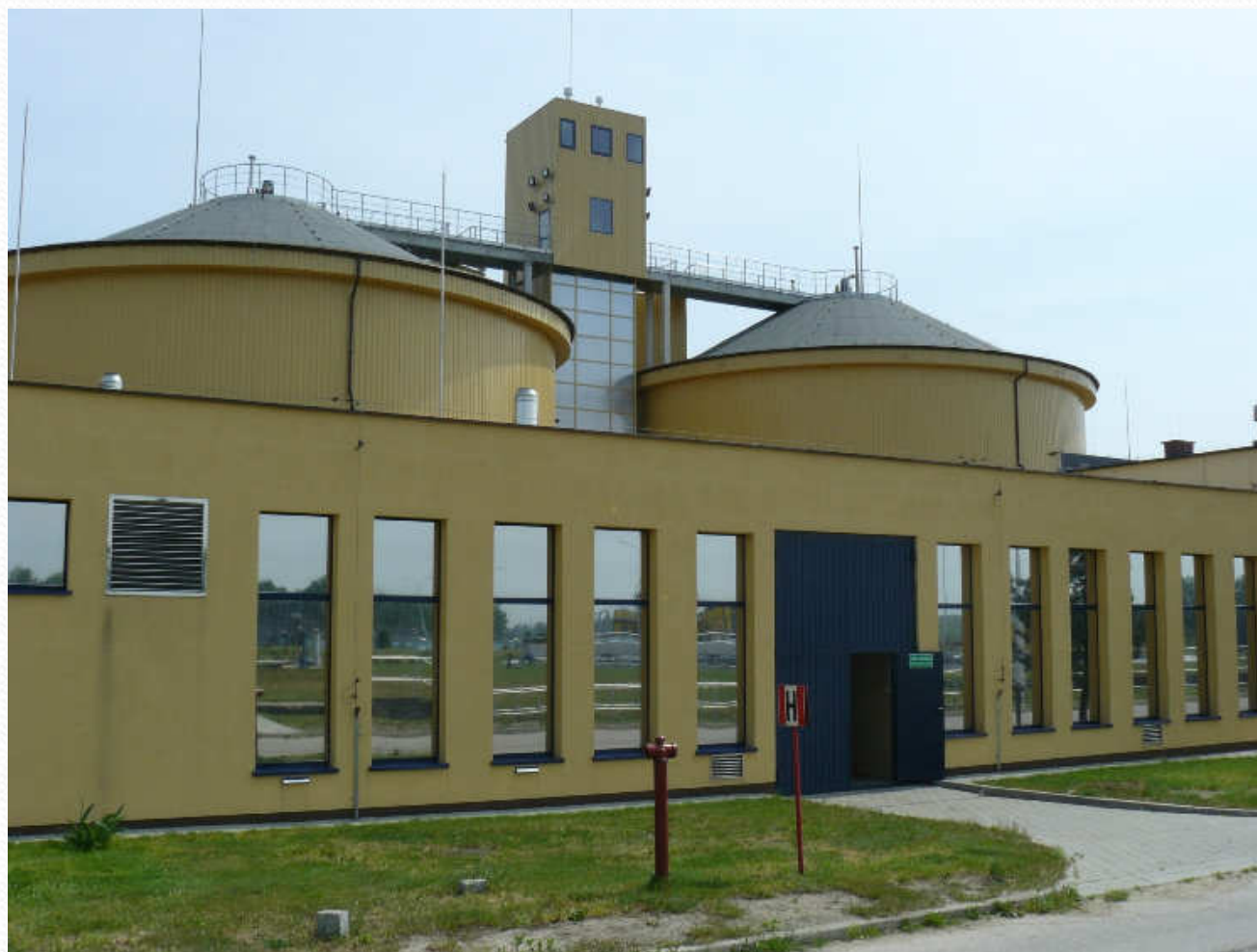
Kotłownia z pomieszczeniem agregatów, w tle komory fermentacyjne
