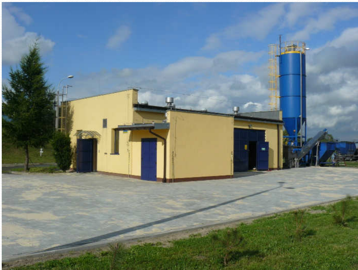
Stacja odwadniania osadu
